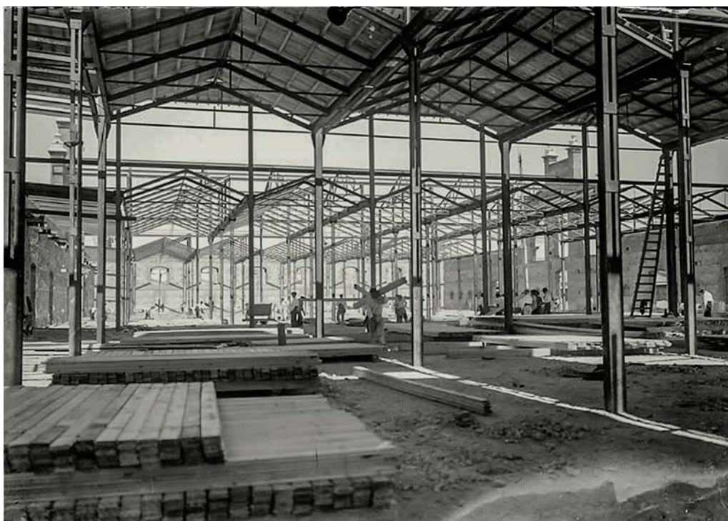
Foto 3. Obras en la Nave de exposición, venta y estabulación de cerdos del Matadero municipal, 1916. Editor: Servicio Fotográfico Municipal. En la fotografía se puede observar la técnica constructiva y los materiales utilizados. CC. Biblioteca Digital Memoria de Madrid.
