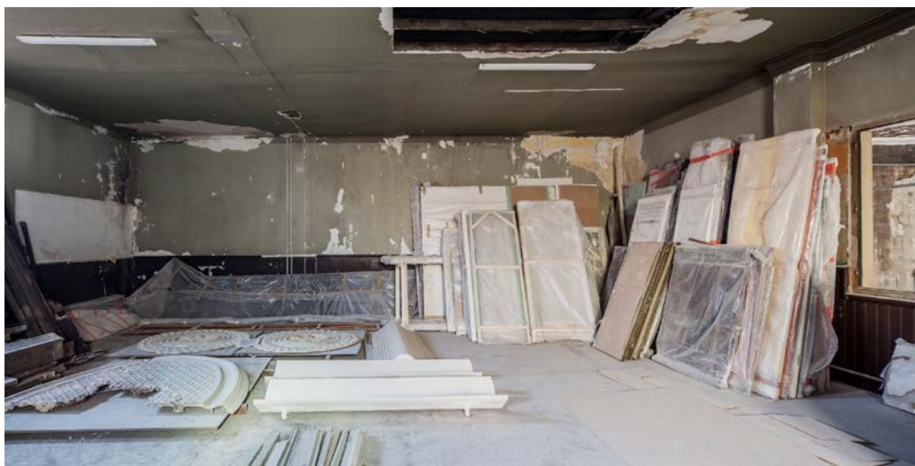
1. La sala Beckett del Poblenou en obres. © Adrià Goula.
