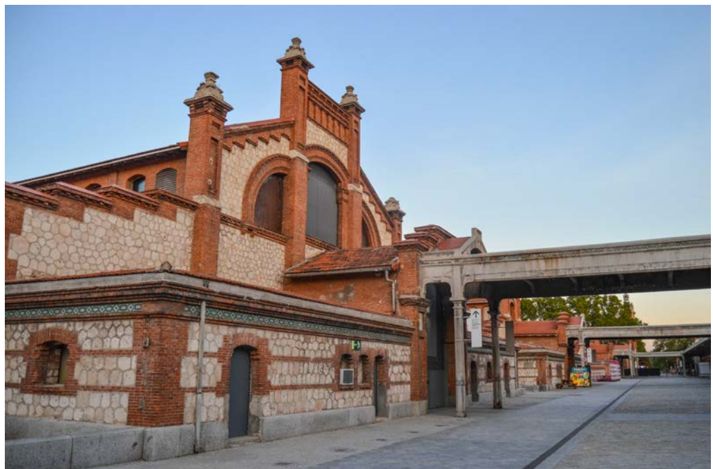
Foto 2. Exterior de las naves de Matadero Madrid. Septiembre de 2018. Elaboración propia.
